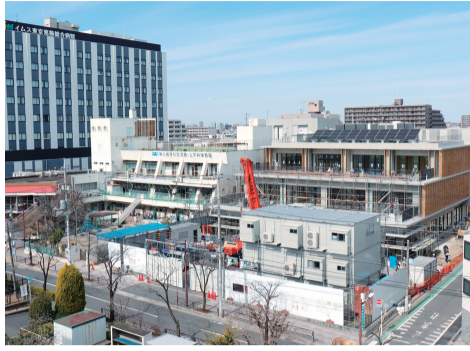
建設中の(仮称)新小岩地域活動センター (にこわ新小岩)
