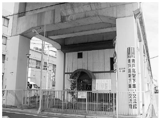
高架下の地域活用（青戸高架下集い交流館）
