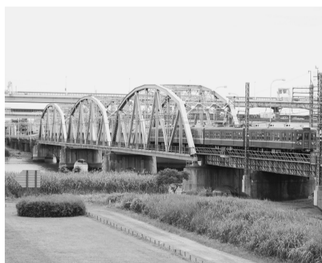
京成本線荒川橋梁
