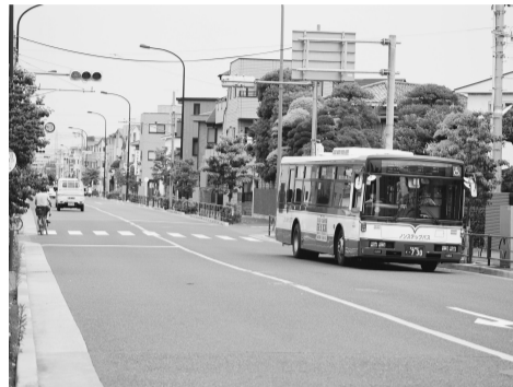
都市計画道路補助第277号線(東金町三丁目付近)
