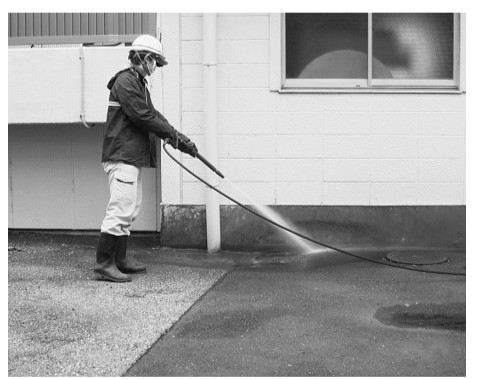
小学校プールの除染作業
