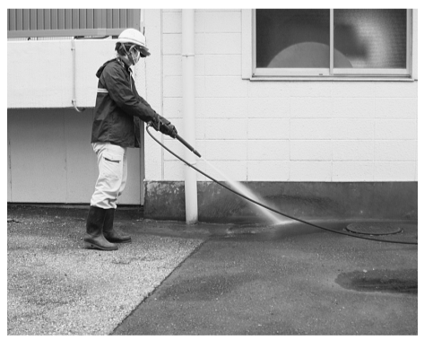
小学校プールの除染作業
