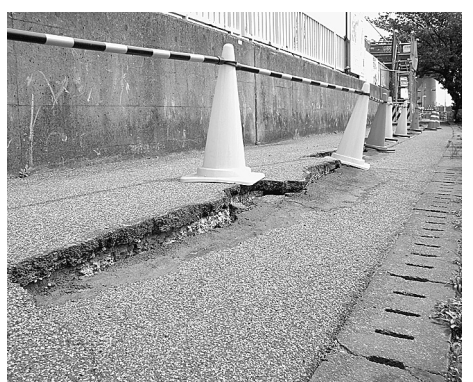
中川堤防道路地割れ補修工事
