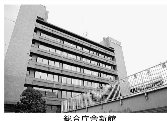
総合庁舎新館
