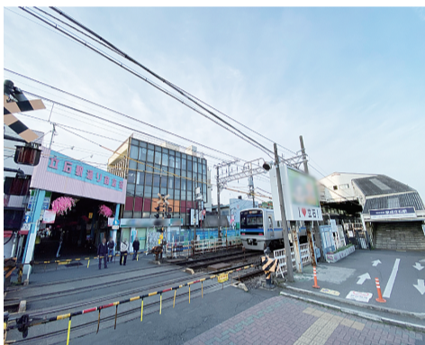
工事が進む立石駅前
