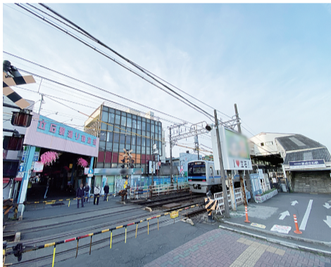
工事が進む立石駅前
