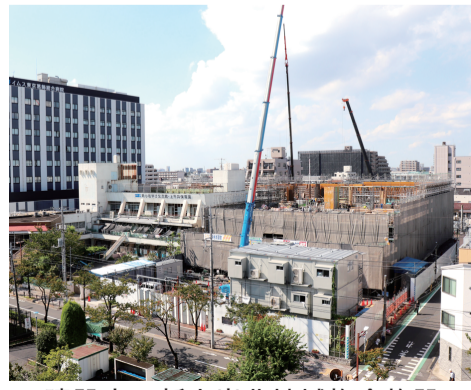
建設中の新小岩北地域複合施設
