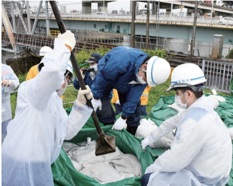
荒川橋梁の水害対策(大型土のうを設置)
