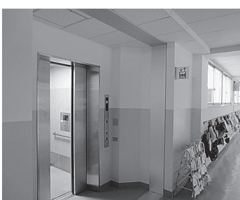
道上小学校のエレベーター
