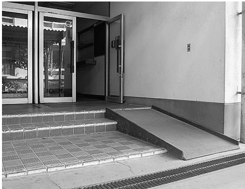
立石中学校のスロープ
