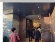
すずらん通りに面した住宅エントランス（入口）
