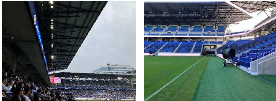
図 106, 107 スタジアムを覆う屋根・送風機稼働の様子
