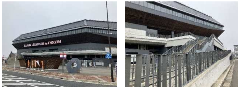
図 61 サンガスタジアムのエントランス・スロープ
