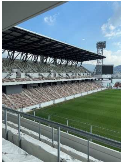
図 91 スタジアムを覆う屋根の様子
