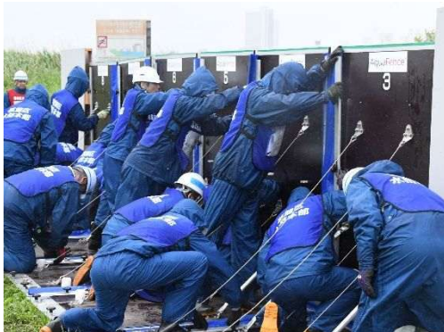
止水板設置状況
