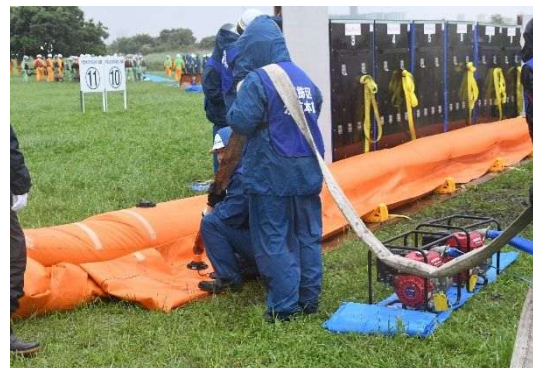
大型水のう設置状況
