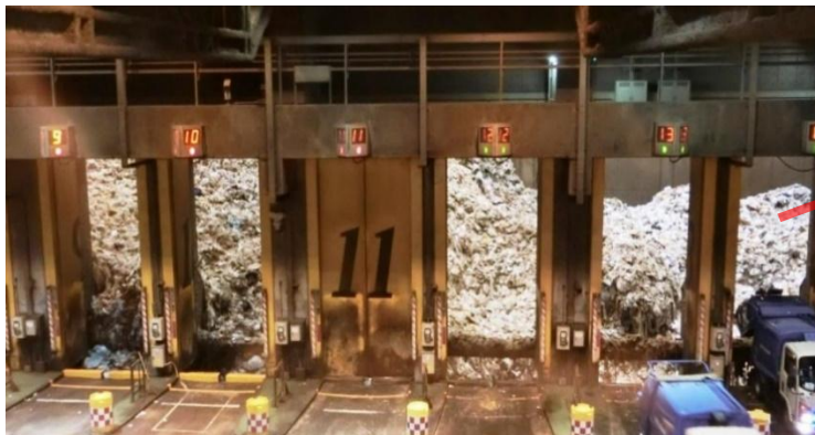
新江東清掃工場 (プラットフォームから見たごみバンク)
