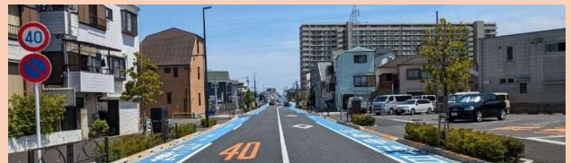
人・自転車・車それぞれが安全で快適な道路 〔区内整備例：補助284号線 東新小岩南区間（幅員16m）〕
