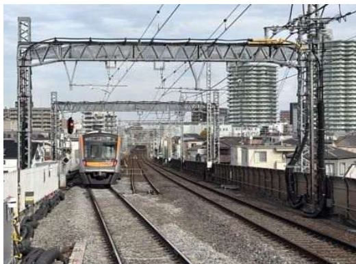
1工区 四ツ木駅方の状況
