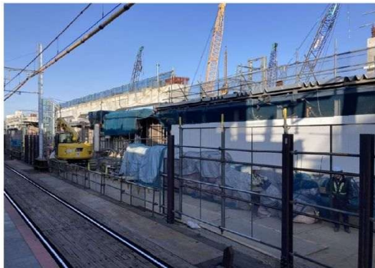
旧下り線ホーム撤去
