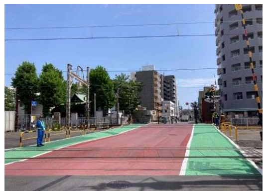
立石2号踏切部 (補助274号線バス通り)
