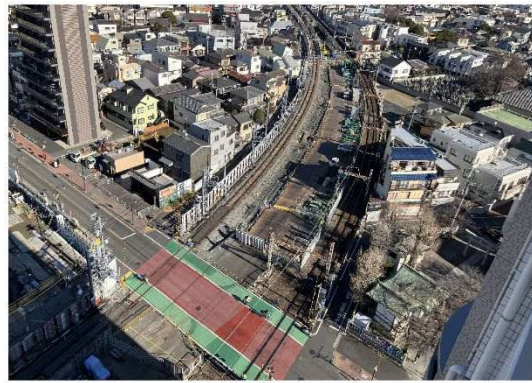
4工区 青砥駅方の状況
