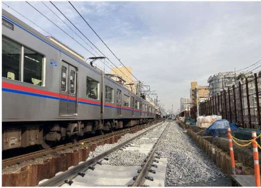
2工区 軌道敷設状況 (立石三丁目付近)
