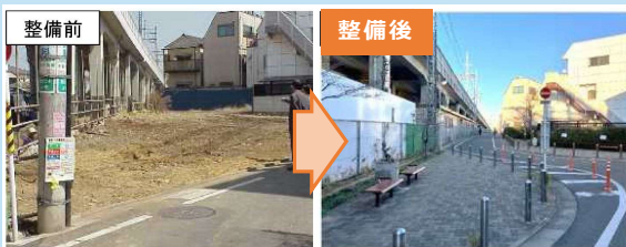
道路拡幅・行き止まり道路解消・建替で防災・減災！ 京成押上線 四ツ木駅付近の南側道路
