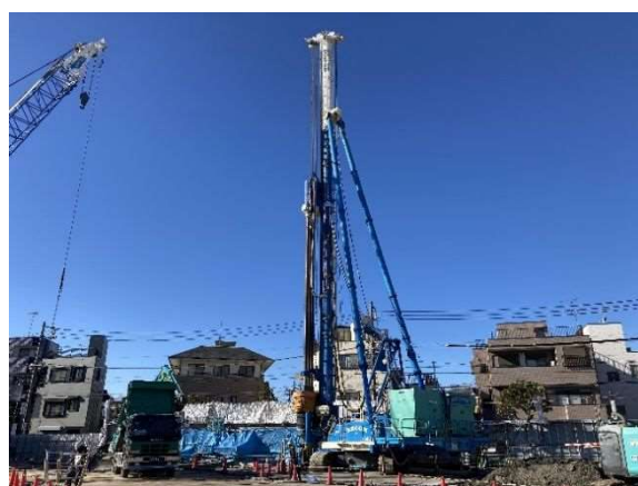
【西棟】山留工事の鋼材打設
