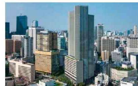
図1-4 地区内残留地区 赤坂、六本木地区
