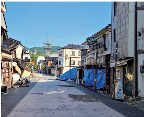
大規模火災が発生した輪島朝市のはいり口
