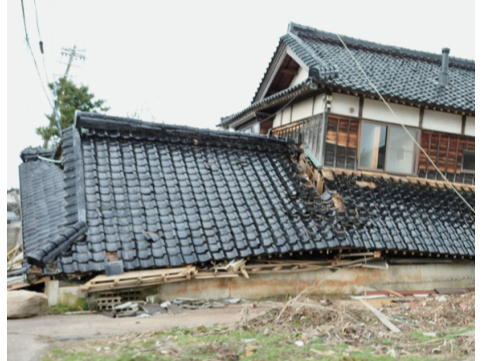
能登半島地震で崩壊した家屋
